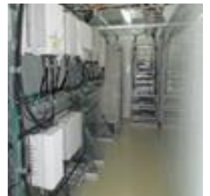
【システム設備工事】
