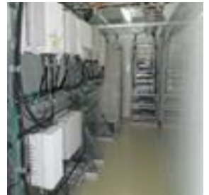
【システム設備工事】
