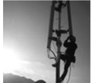
【情報通信設備工事】
