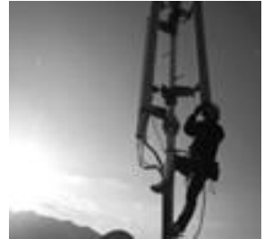
【情報通信設備工事】
