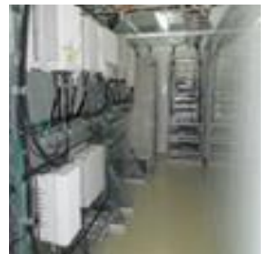
【システム設備工事】
