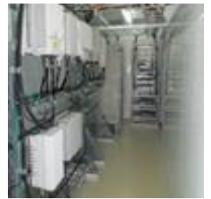
【システム設備工事】
