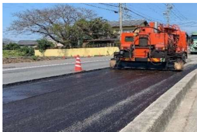
【土木工事一式】
