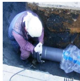
【水道施設工事】
