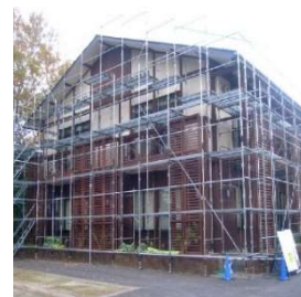
【建築一式工事】
