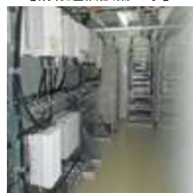
【システム設備工事】
