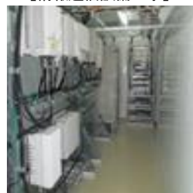
【システム設備工事】
