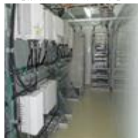
【システム設備工事】
